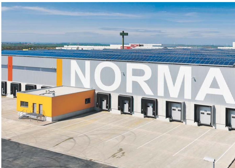
Neben den Filial- und Niederlassungsbauten bringt Norma auch die Logistikzentren auf den neuesten Stand wie hier in Erfurt. Bild: Norma
